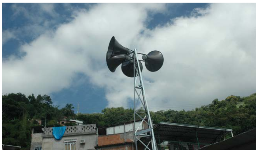
Figura 6.21 – Sistema de Alarme e alerta sonoro: instalação de sirenes.
